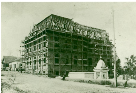
Figura 49 Construção do prédio do Colégio São Luiz (autoria e data desconhecidas).
